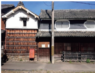
明治期建築の古民家 診療所兼住居蔵2棟あり
