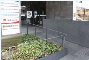
段差解消スロープと点字ブロックの設置
