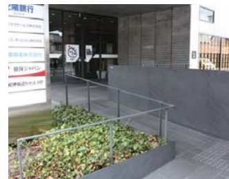
段差解消スロープと点字ブロックの設置
