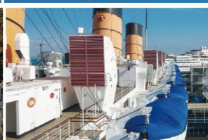
船舶・海洋施設
