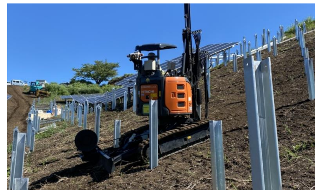
同社が自社開発した特殊重機による ダウンザホールハンマー工法
