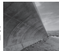
津波避難困難地域解消のための堤防整備
