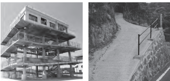
津波避難タワーや避難路の整備
