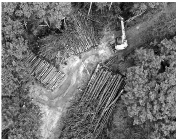
写真-4 土場での丸太の仕分け（ドローンより）
