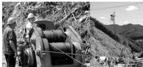
写真-2 大型ウインチによる架線集材
