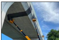
剥落防止ネット 設置工事の様子
