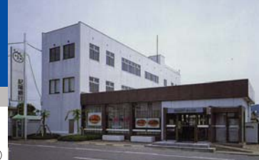
岩出支店(岩出市)
