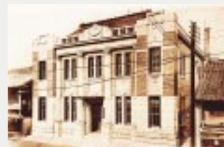
大正8年に新築した本店外観
