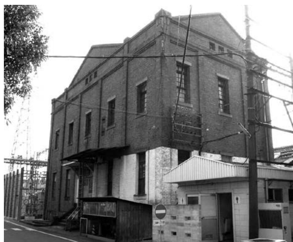
三菱電機変電所
