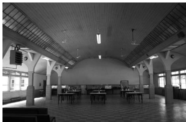
大和紡績・食堂内部
