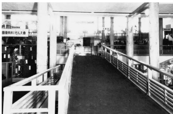
和歌山高島屋内部 見上げ（高島屋史料館所蔵）
